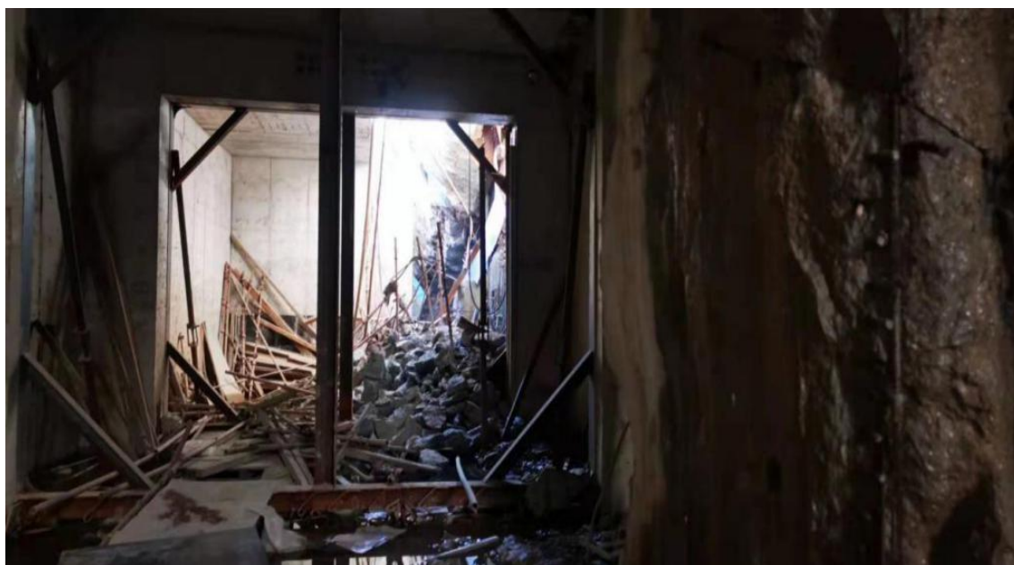
图 13-2 新风井内现状
