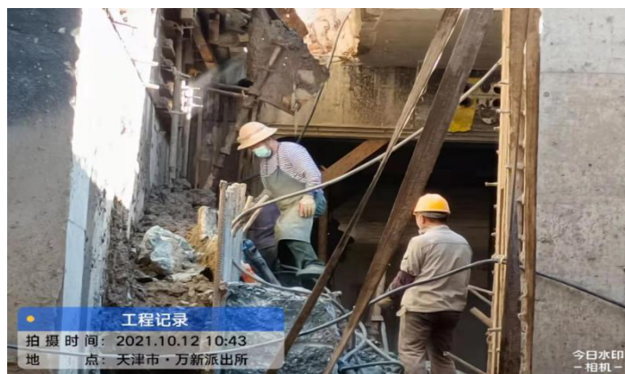
图 8 事发当日 2 号地连墙临时支撑墙凿除情况
