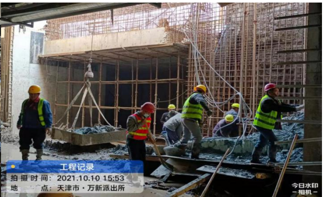
图 7-2 1 号地连墙临时支撑墙凿除过程
