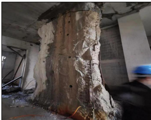
图 9 3 号地连墙临时支撑墙
