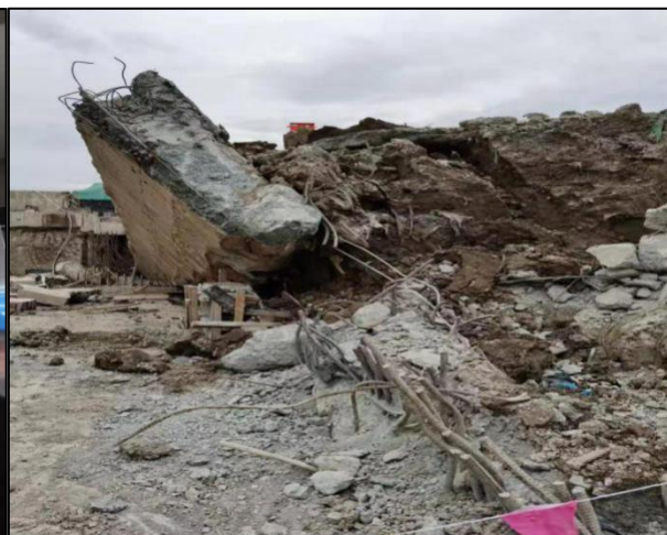
图 10 3 号地连墙临时支撑墙与冠梁连接钢筋
