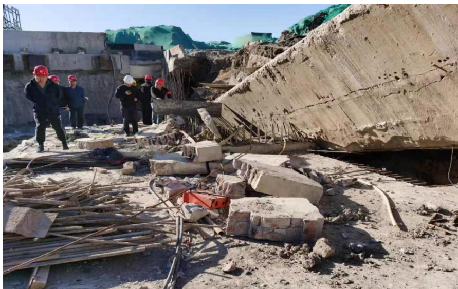
图 14 顶板上方散落的红砖挡水墙
