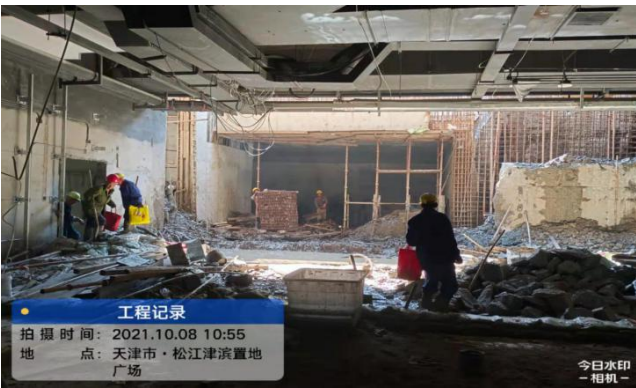
图 7-1 1 号地连墙临时支撑墙凿除过程
