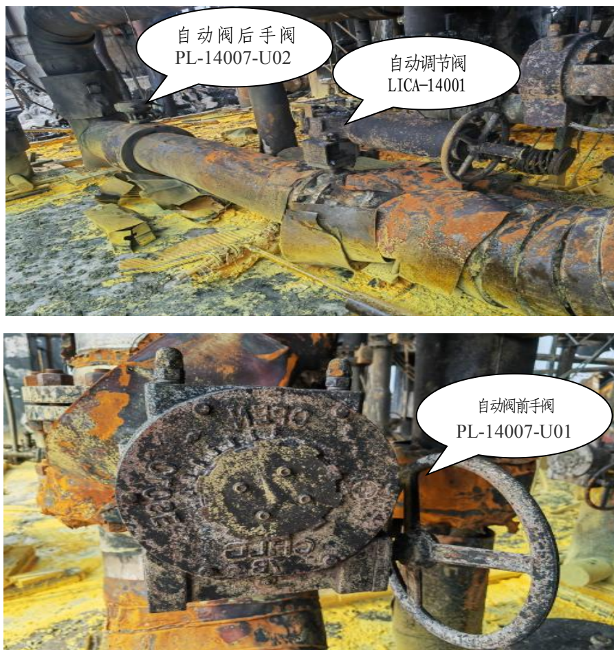
图 6: 自动调节阀及前后手阀现场照片
